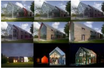
شكل ٧ تغير التشكيل مع تغير الحركة في السقف و الحوائط للمنزل المنزلق المصدر :
