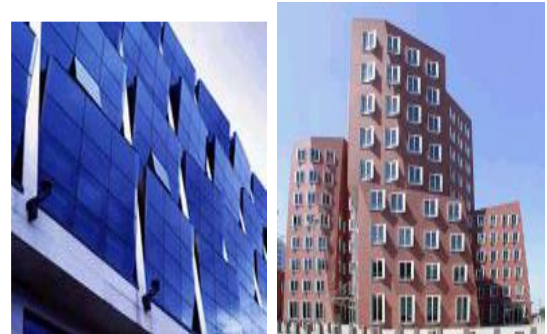
شكل رقم (13) استخدام الكاسرات الأفقية والرأسية المتحركة
