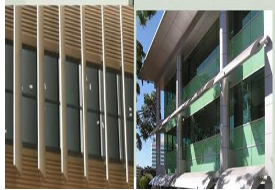
شكل رقم (13) استخدام الكاسرات الأفقية والرأسية المتحركة
