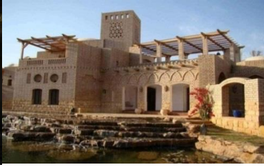
شكل رقم (10) استخدام الملقف في المباني والاستفادة من طاقة الرياح الطبيعية 5
