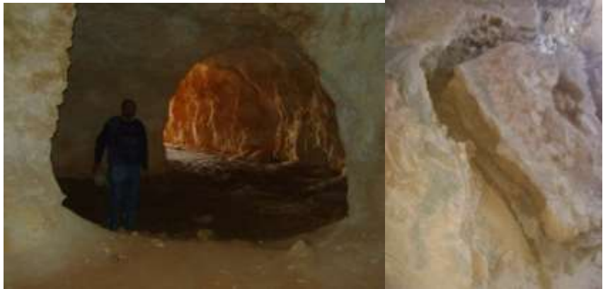
صورة (١٨) تخذدات علي جانب النفق (١) صورة (١٩) مجري خانقي بالنفق (٦)
