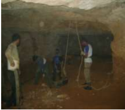
صورة ( ٢٢ ) استخراج الرواسب من النفق ( ٤ ) صورة ( ٢٣ ) استخراج الرواسب من النفق ( ٣ )
