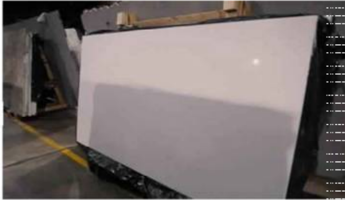
عناية لقص البلاط (تاسوم) وتجهيزها لتركيبها في المسجد الحرام
