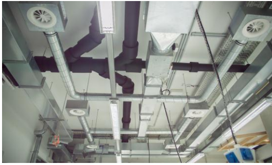
شكل (٢٨) يوضح تجهيزات الأسقف بنظام متطور لتوزيع الهواء بأحد معامل الترميم بالمتحف Anton Ulrich Museum, Brunswick, Germany.
