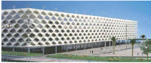
شكل (٢٠) التظليل باستخدام الأشعة الشمسية بمكتبة الملك فهد الوطنية ، الرياض ، المملكة العربية السعودية.
