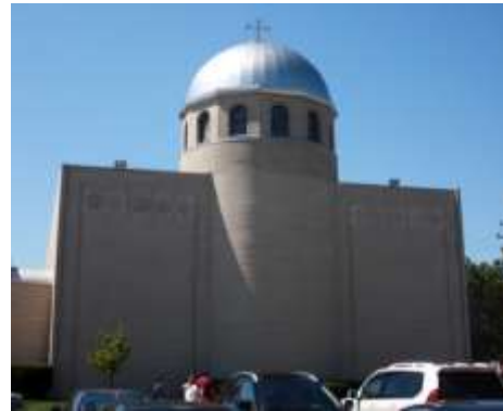
(شكل 17) القبة المعدنية فوق الهيكل ويظهر الطابع القبطي للمبنى والقبة الفولاذية الرئيسية
