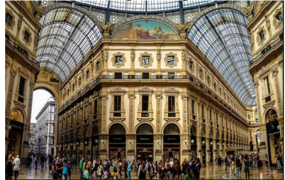
شكل رقم (17) لقطة بساحة ممر بفيكتوريو إمانويل الثاني Vittorio Emanuele II من أكثر الأماكن السياحية بميلانو، أنشاء عام 1877م بفراغ وسطي مغطى بقبة زجاجية، تسمح بتوفير الإضاءة الطبيعية (32) .
