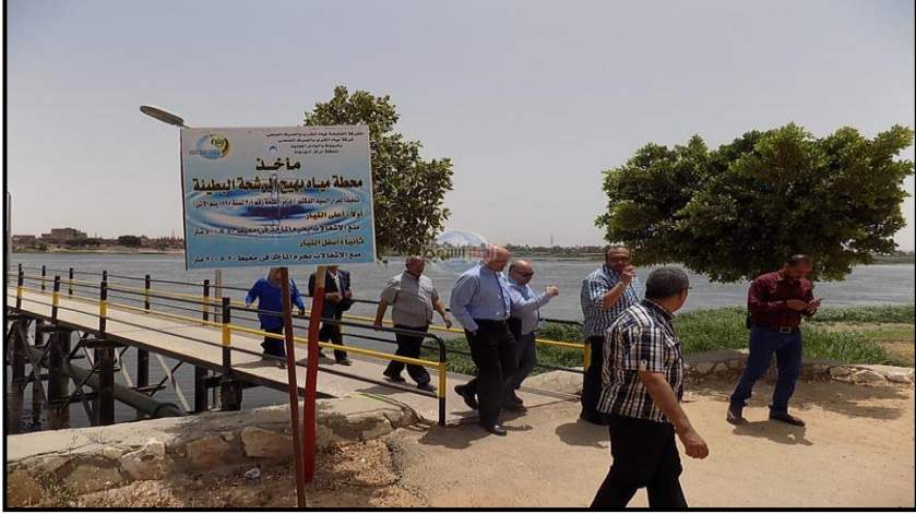
صورة رقم (٣) محطة مياه بهيج، قرية بهيج — مركز أسيوط
