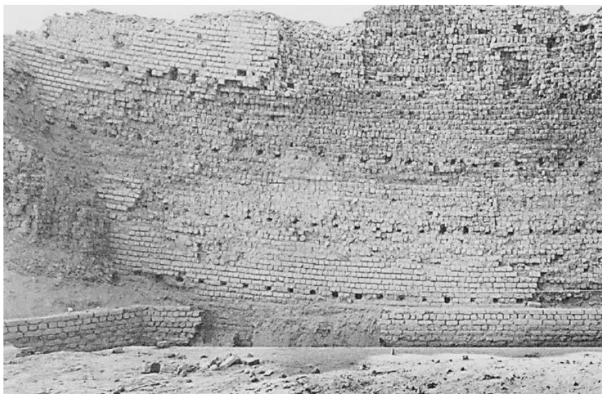
(لوحة ٤) صورة تعود لمنتصف القرن الماضي توضح سقالات البرج الشمالي بالصرح الأول بالكرك
