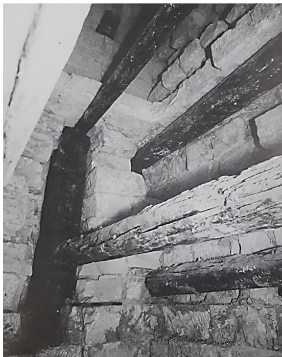
(لوحة ١٥) حماية غرفة الدفن العلوية بهرم سنفرو المنحني بخمسة أعمدة عمودية ربما استخدمت كسقالة.
