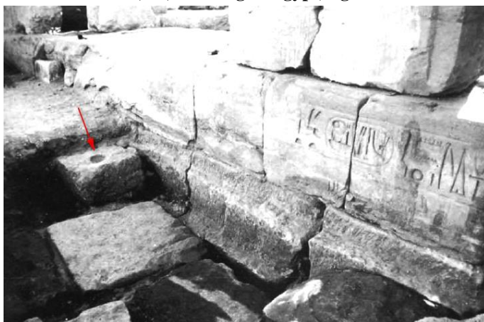
(لوحة ١٢) بؤرة ربما لسقالة بالركن الجنوبي الشرقي من فناء الصرح الرابع بالكرنك.
