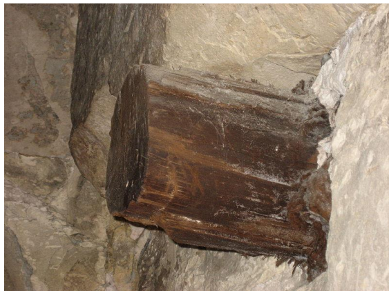
(لوحة ١٤) دعامات خشبية في السقف المكربل لحجرة الدفن بهرم ميدوم.
