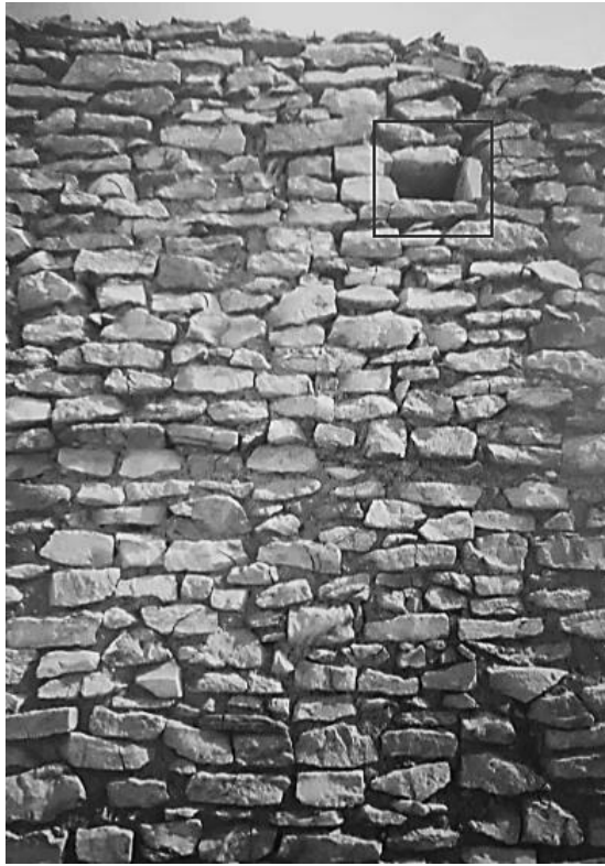
(لوحة ٩) فتحة بأحجار اللب الأساسي لهرم ببي الثاني بسقارة يعتقد أنها كانت لتثبيت السقالات.
