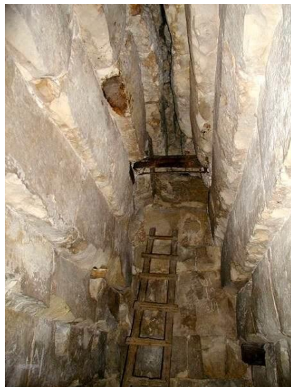
(لوحة ١٤) دعامات خشبية في السقف المكربل لحجرة الدفن بهرم ميدوم.
