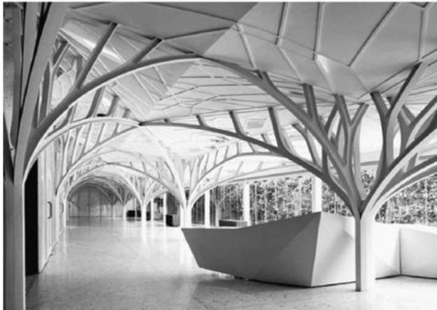
صورة(14) توضح عملية المورفولوجى الرقى من التصميم البيولوجى L-System لمطعم Tote Restaurant ، فى بومباي ، من تصميم (Serie Architects) ، عام 2009.(17)
