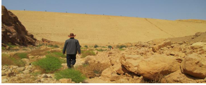
صورة (٢) : توضح ردم مجري ثانوي لوادي ام جلاوات بهدف تعديل مسار الطريق الساحلي، ويلاحظ عدم وجود مخرات للسيول وتكون بحيرة مؤقتة بلغ ارتفاعها نحو المترين عقب سيول ٢٠١٦.
