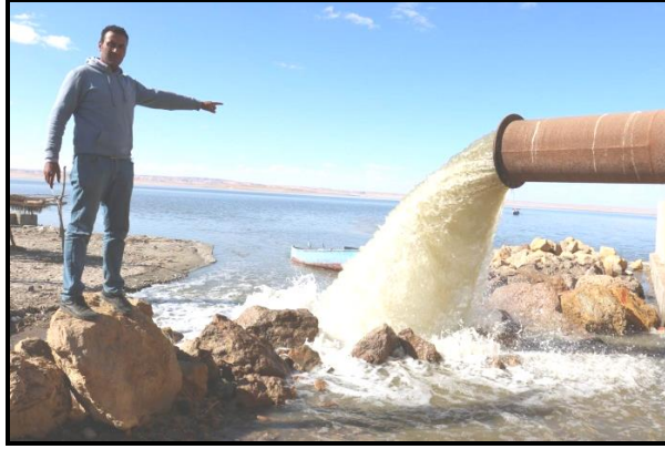
صورة (5) : صرف المياه في البحيرة بواسطة محطة رفع عداقوي شعيتان جنوب شرق البحيرة.
