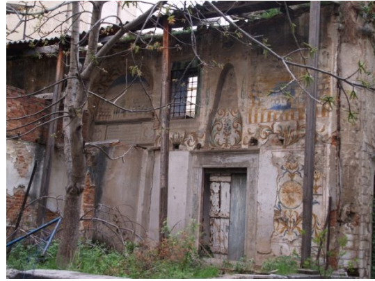
شكل 16. جامع محمد خليل أغا، الواجهة الشمالية الغربية (الرئيسية)، وهي تمثل الواجهة الداخلية للرواق الخارجى حيث يتوسطها مدخل الجامع، تصوير الباحث
