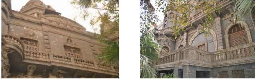
شكل (٢٦) صورة ميدانية توضح الشرفات بواجهات القصر
