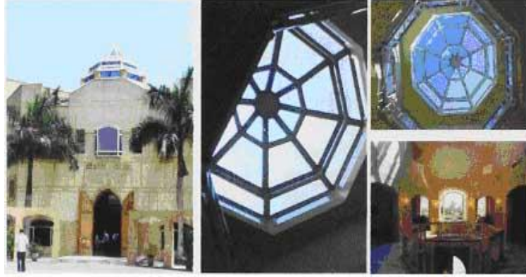
صورة (١٦) ، استخدام الشخشيخة المثلثة في مدخل مبنى قصر الفنون
