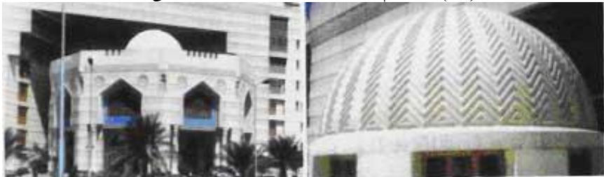
استخدام القبة بمبنى المشيخة صورة (١٢)
