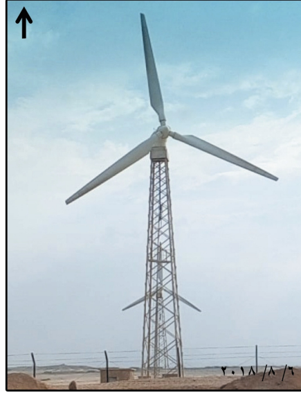
صورة (١) : نموذج لتربينات الرياح ذات الأبراج المربعة بمحطة رياح الغردقة.
