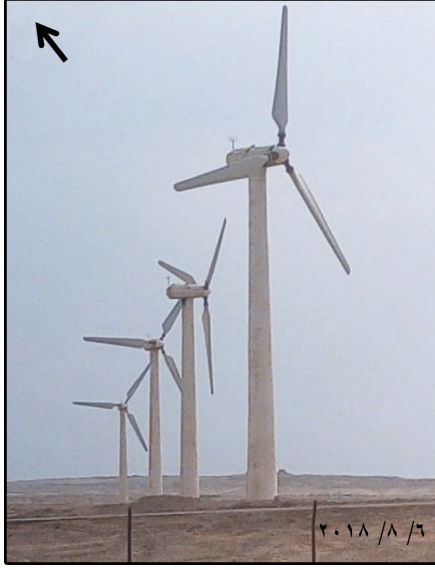
صورة (٢) : نموذج لتربينات الرياح ذات الأبراج الاسطوانية بمحطة رياح الغردقة.
