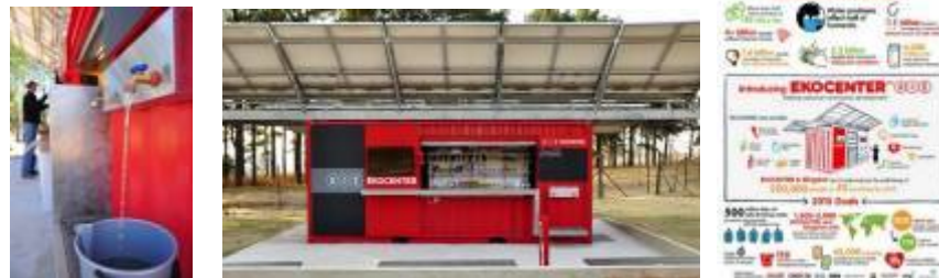
شكل (12) تحويل حاوية الشحن إلى محطات تنقية المياه. يطلق عليها اسم Ekocenter
