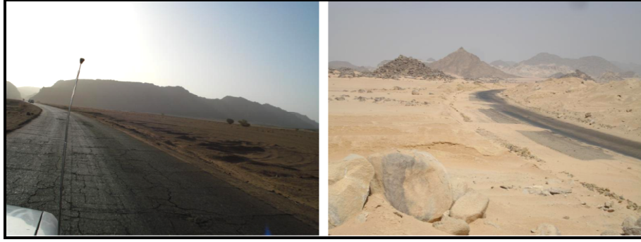
شكل (١٦) : زحف الرمال، والتشققات التي تظهر على طول طريق أسوان - العلاقي. المصدر: التصوير الفوتوغرافي أثناء الدراسة الميدانية التي أجراها فريق المشروع البحثي (٢٩/٣/٢٠١٥).
