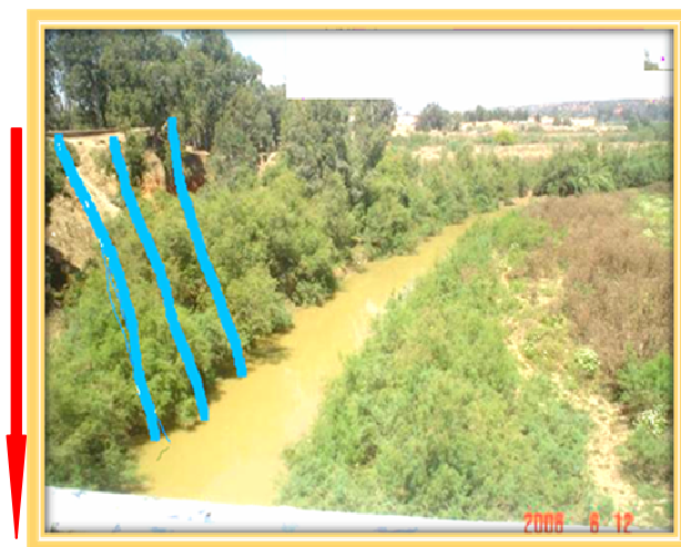
Photo 02: Le cours d'oued Cheliff passant par la ville de Chlef, en période. (étiage) Ceci est montré à travers le lit de l'oued.
