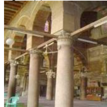
صورة (1) الأعمدة أحد أهم عناصر التكوين الإنشائي بالوحدات الرأسية - مسجد الماراداني.
