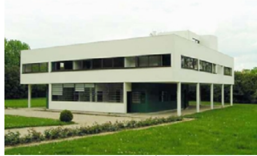
شكل (٩) فيلا سافوي - المعماري لوكوربوزييه استخدام المسقط الحر الذي يتشكل طبقاً للوظيفة والتأكيد على استقلالية المبنى عن الطبيعة وسيطرته عليها
