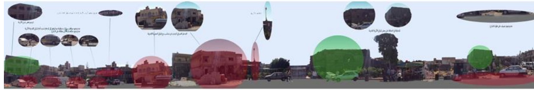
جزء من الواجهة الشرقية
