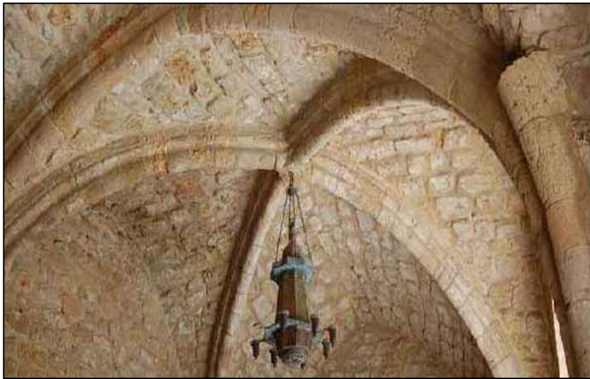
صورة رقم ١٠: الجامع العمري الكبير في صيدا. يتميز الرواق الشمالي بالعقود المتقاطعة المضلعة ذات الطراز القوطي و يرجح انها تعود الى تاريخ البناء الاصلي.
