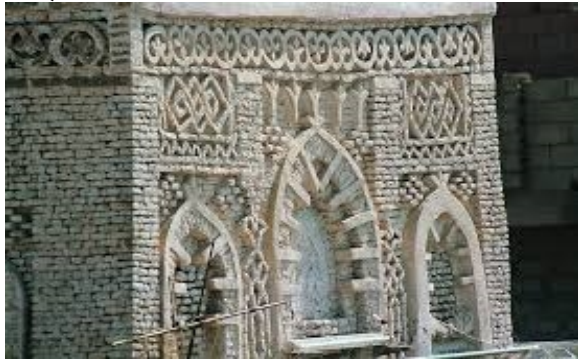
(شكل ٢٣) التشكيل بالطوب في الواجهات بمدينة زبيد
