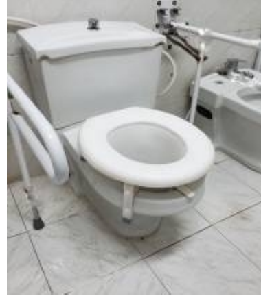
صورة (١) توضح استخدام مقعد حمام مرتفع وقضبان مستقلة آمنه للمساعدة على النهوض
