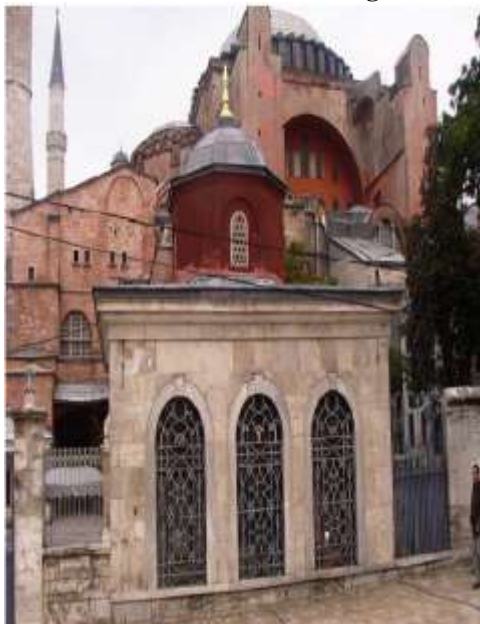
لوحة (١٥) الواجهة الجنوبية للمؤقتخانه بكلية
