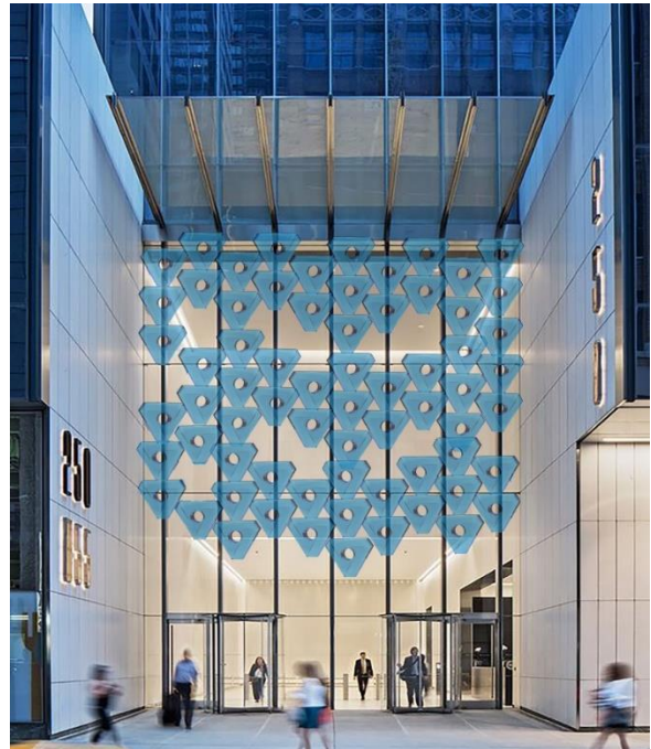
التطبيق في العمارة الخارجية بوحدة مفرغة شفافة زرقاء اللون مستخدماً مسامير التجميع السابق ذكرها مستعينا بهيكل معدني
