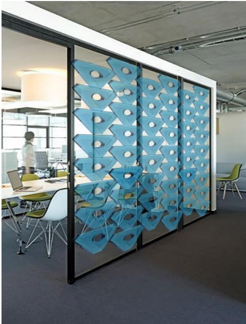
التطبيق في العمارة الداخلية بوحدة مفرغة شفافة زرقاء اللون مستخدماً مسامير التجميع السابق ذكرها مستعينا بإطارات معدنية للتثبيت
