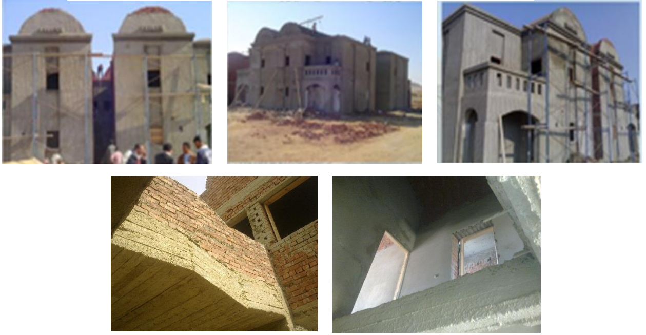
شكل (١١) صور مجمعة لمواد البناء المستخدمة في المشروع واستخدام القباب
