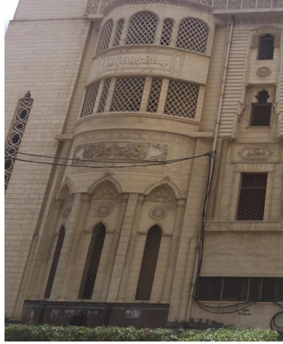
لوحة ١٤ : طرف الواجهة الشمالية لجامع ياقوت العرش ( تصوير الباحثة)
