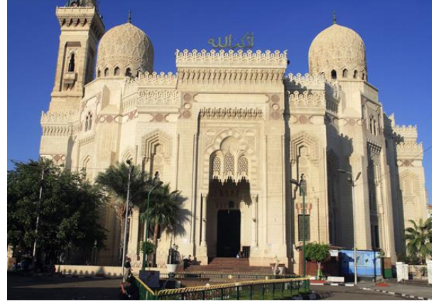
لوحة ٦ : الواجهة الجنوبية لجامع أبي العباس المرسي (تصوير الباحثة)
