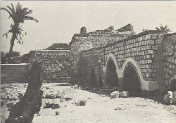
جسر جنداس: ويقع شمال مدينة اللد وبنى في عهد المملوك الظاهر بيبرس يبلغ طوله ٣٠ متر وعرضه ١٣ متراً وارتفاعه ٦.٥ متر.
